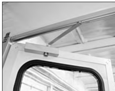
Рис. 47а. Установка доводчика. Калитка открыта
