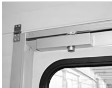
Рис. 47. Установка доводчика. Калитка закрыта
