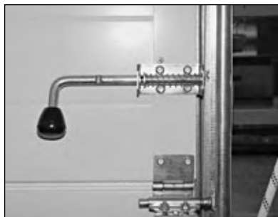
Рис. 39. Установка засова. Положение "открыто"
