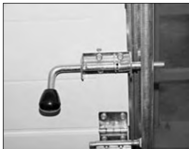
Рис. 39а. Установка засова. Положение "заперто"
